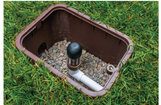
Entlüftungs-/Druckausgleichsventil installiert
